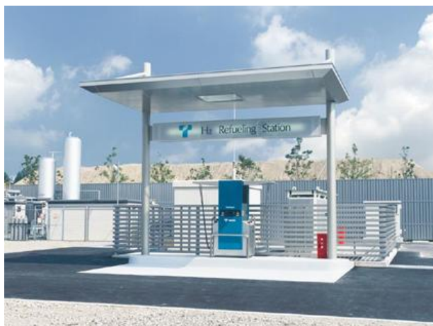
図5 水素供給ステーションの外観
