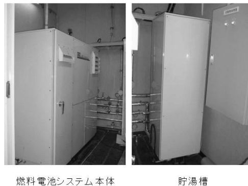
図 7. 独身寮における灯油型燃料電池システム
