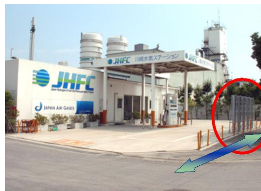
図 1 ステーションと公道の間に設けたポリカーボネート製の壁
