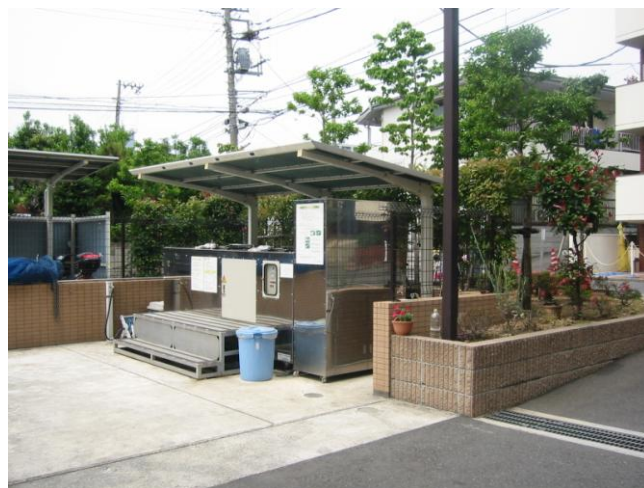
マンションの一面にある処理装置
