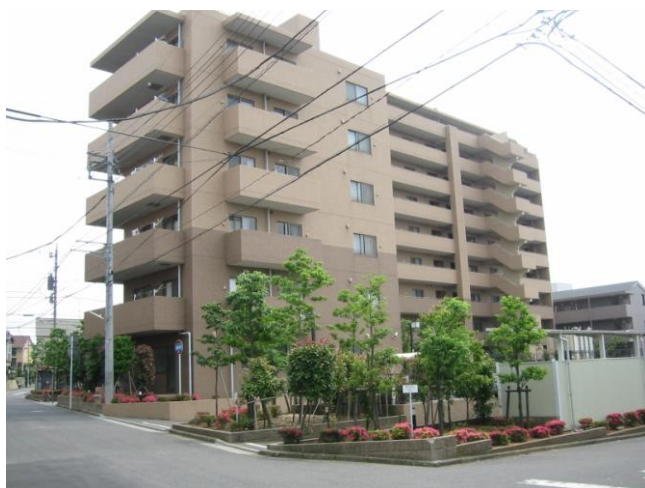
生ゴミ処理装置を設置したマンション
