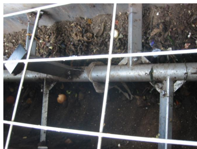
生ゴミの投入状況
