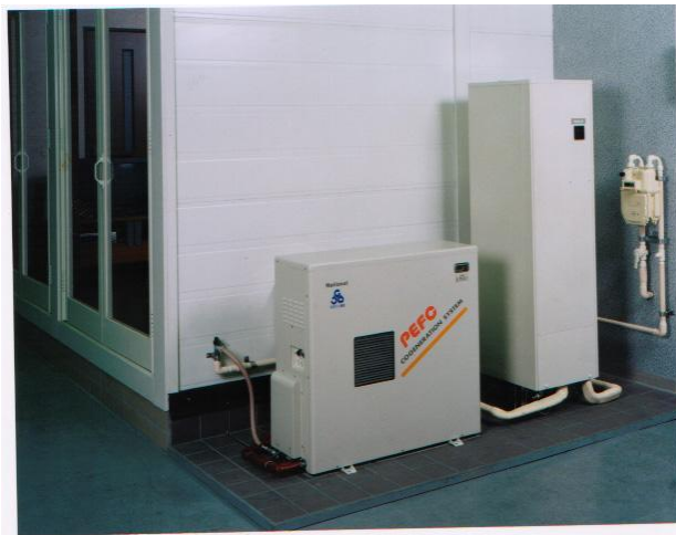
図-4：定置式燃料電池用改質器
